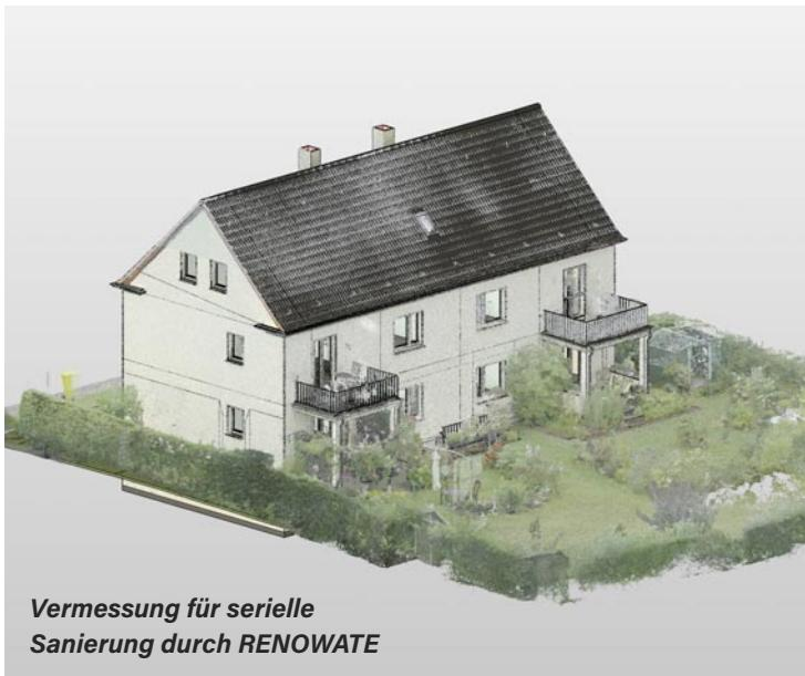
**Vermessung für serielle Sanierung durch RENOWATE**
